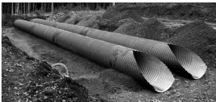
Рис. 12.3. Общий вид гофрированных труб со срезом
