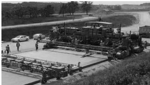
Рис. 20.9. Строительство цементобетонного покрытия бетоноукладчиком со скользящими формами
