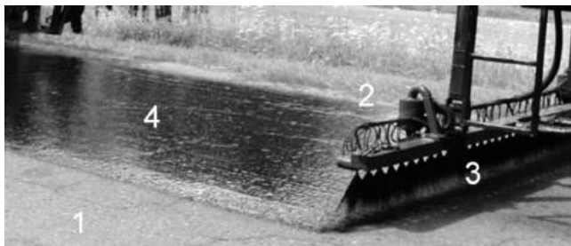
Рис. 19.7. Нанесение битумной эмульсии:
