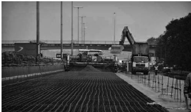
Рис. 20.13. Устройство непрерывно армированного цементобетонного покрытия
